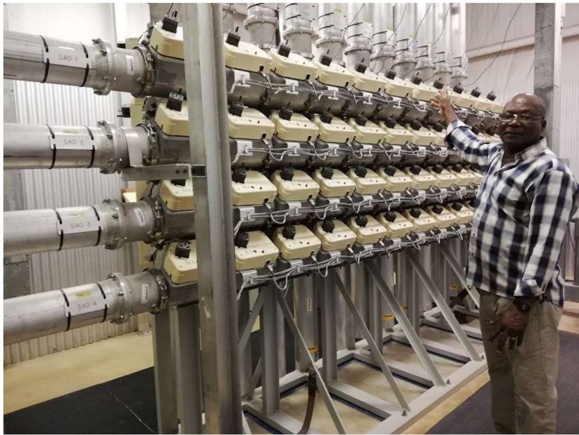
Figura 3. Funcionamento da matriz que conduz as guias de onda para as antenas emissoras.
