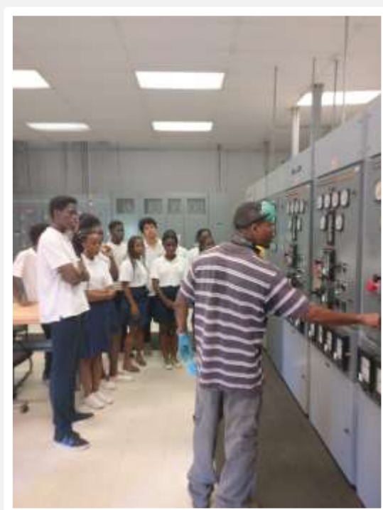
Figura 3. Funcionamento automático dos geradores.
